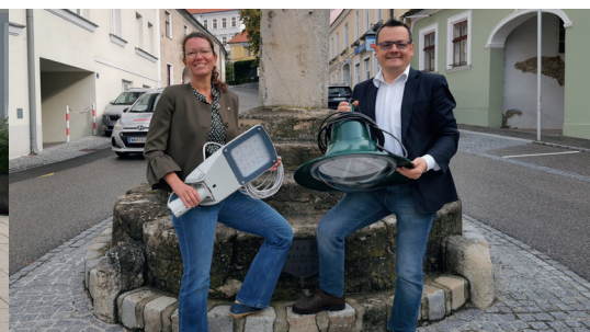
Neue Straßenbeleuchtung Wölbling am neusten Stand der Technik
