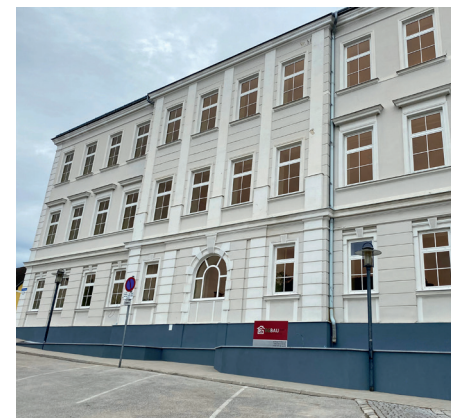
Ansicht nach dem Umbau
