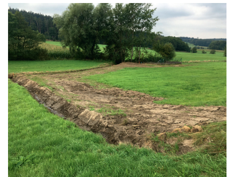
Viehausen: Zusätzliche Grabenräumung
